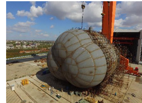
Final erection by 1000T crane 利用1000T龙门吊液罐总组
