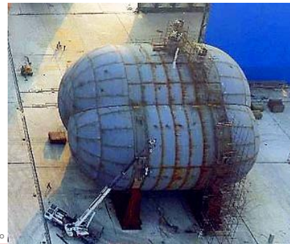
Pressure test 水压试验
