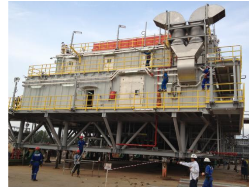
Load out 模块出运
